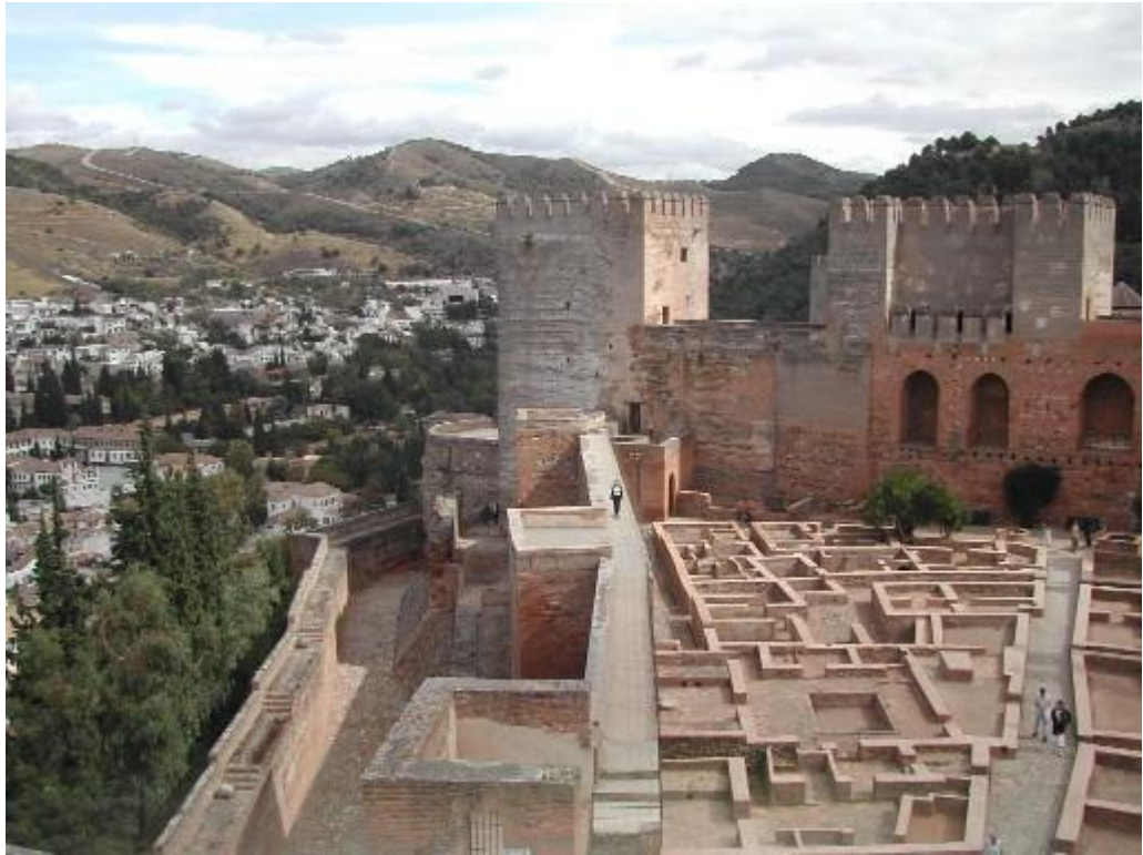
北側城壁の内部。本来は兵舎でもあったんですが、残っているのは基礎だけ。
