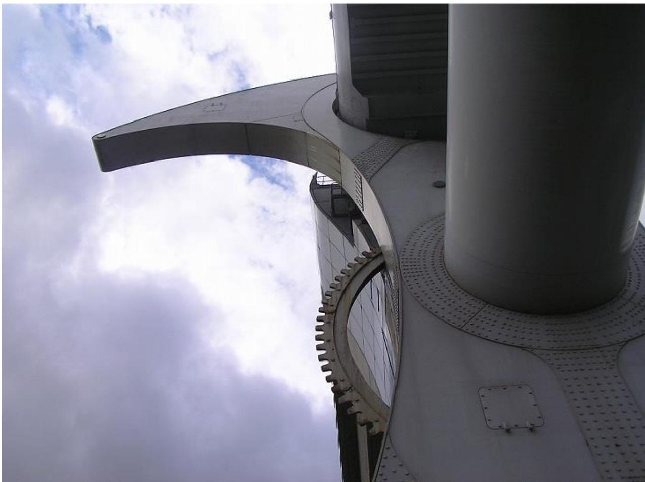
アームに多数のボルトの頭が見えます、金属疲労による不測の事態を避けるために、部材接合には溶接を多用せず、より安全なボルト・ナットでの接合を採用したのだそうです。
