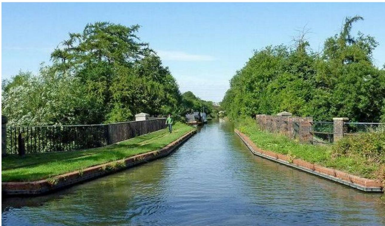
ボンヤリ走っていたらこれが水道橋だとは気づかずに通り過ぎてしまうでしょうが、水路巾の狭まりと両側の手摺りに気が付けばソレと分かる筈。 右側の手摺りの石柱はかなり年季が入っているようで、18世紀末の運河建造当時の物がそのまま残っているのかも知れません。 上の画像の右下の地面からこの水道橋を見上げたのが次の画像。
