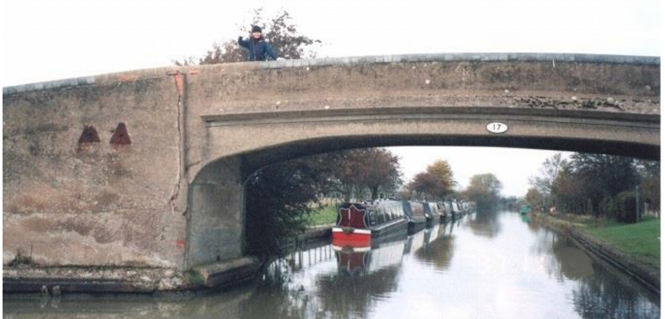
上は Napton Junction 中央部から Bridge 17 と Birmingham に向かう Grand Union
